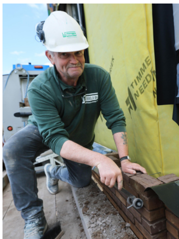
Gerrit Nijboer werkt de voegen bij. FOTO'S DE TELEGRAAF
